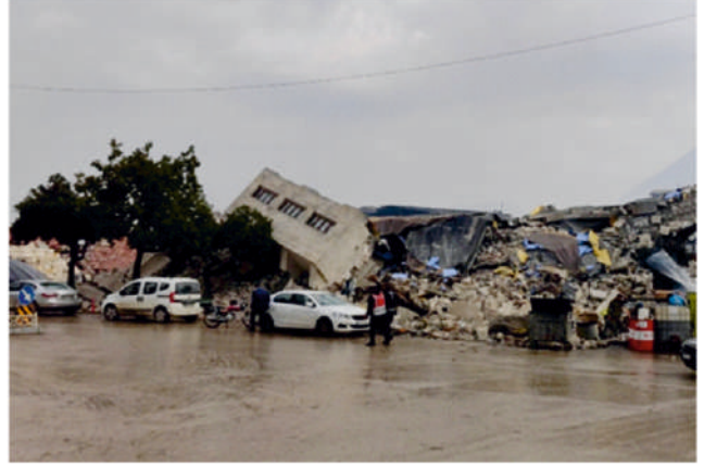
Hatay Eski Meclis Binası - 20 Şubat 2023 - Depremler Sonrası
